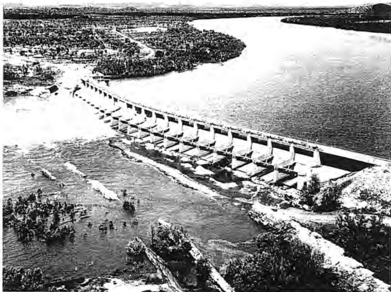
Kununurra Diversion Dam
