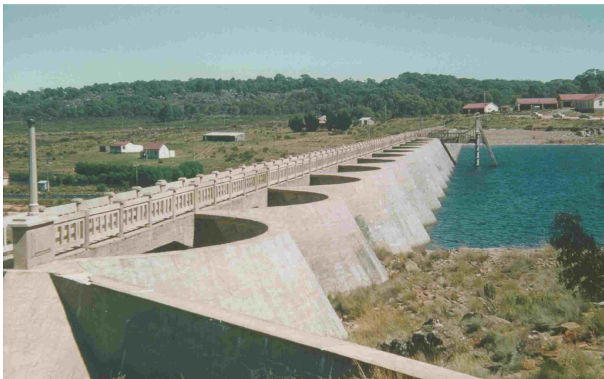
Miena Dam No. 2
